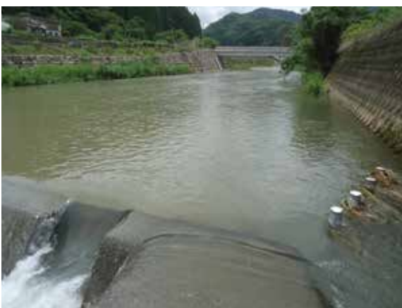
頭首工（取水堰）
