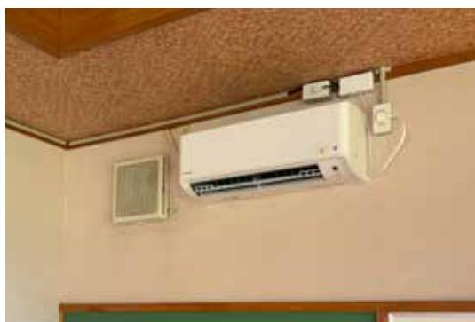
▲設置されたエアコン
