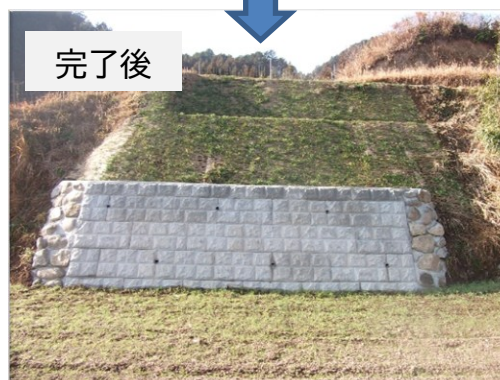
R5年災・農地災害復旧工事(栗林地区)
