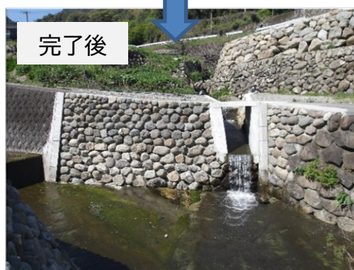
宝珠山川緊急対策工事(竹地区)
