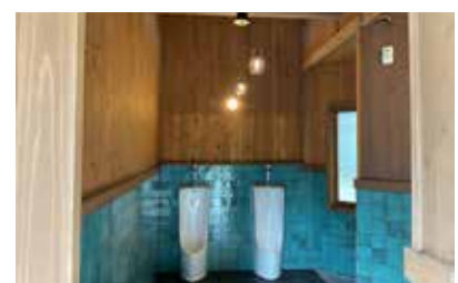
▲改修後のトイレ②
