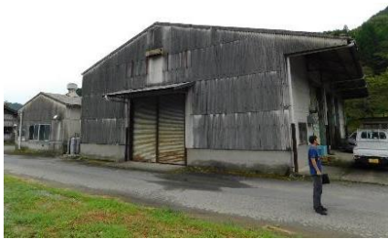
JA筑前あさくら乾燥加工場
