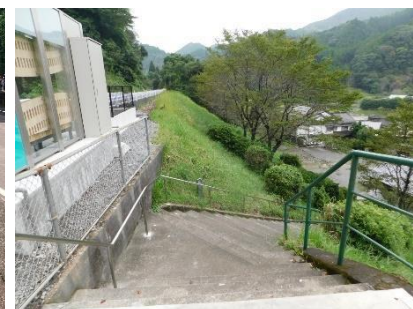
ホームまでの階段（上から）
