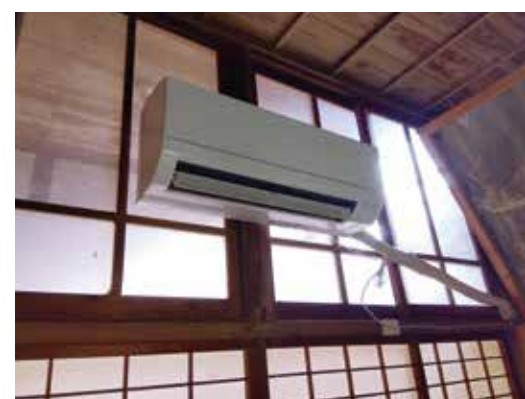
高齢者宅 室内エアコン取付写真
