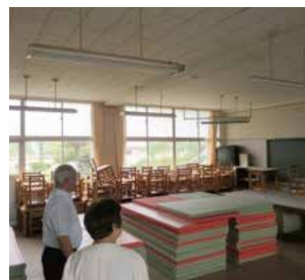
校舎内部の現地調査
