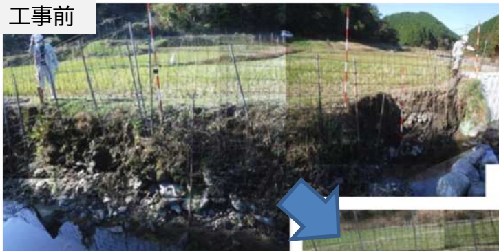
奥畑川河川災害復旧工事(小石原北区)
