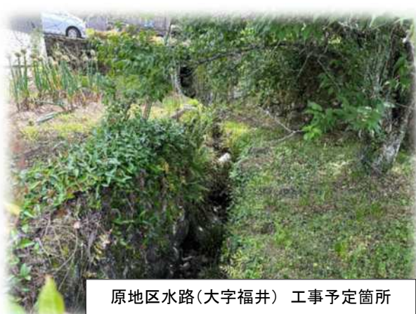
【緊急自然災害防止対策事業 河川防災工事の一例】
