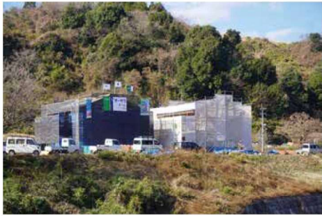
建設中の単身者用住宅(小松団地)
