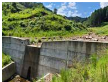
大山林道にある治山ダム
