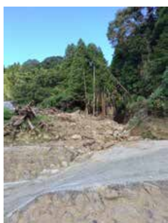
蔵貫地区の土石流箇所 (2カ月後)
