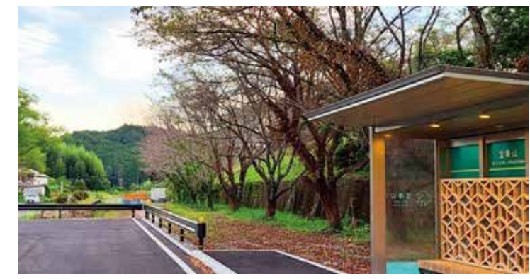
BRT停留所と整備予定地 (写真奥)
