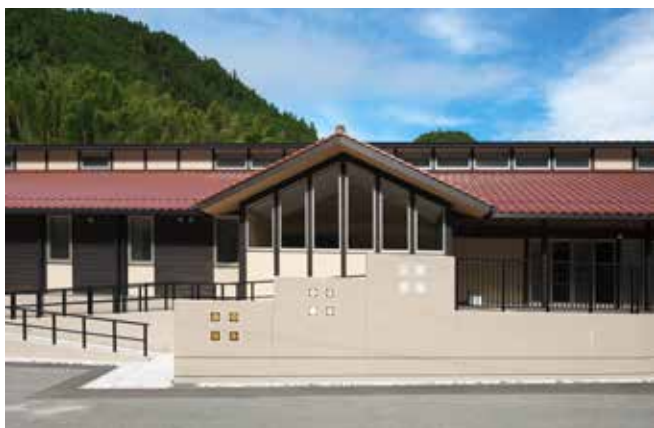
▲正面玄関入口付近
