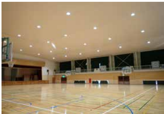
▲新しくなった村民センターの照明
