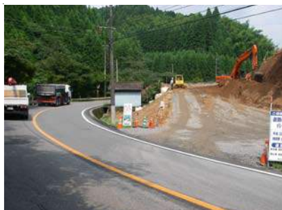
▲現在工事中の湯の谷地域
