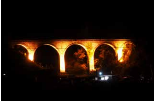
▲栗木野橋梁 (通称：金剛野橋)
