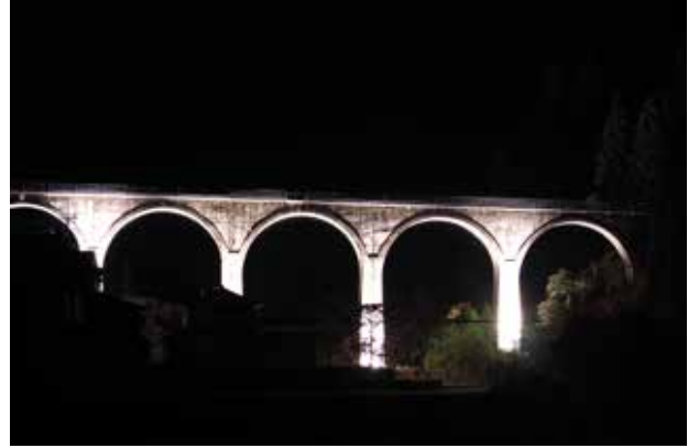
▲宝珠山橋梁 (通称：奈良尾橋)
