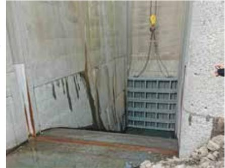
▲ 試験湛水のために閉塞された仮排水路流ゲート
