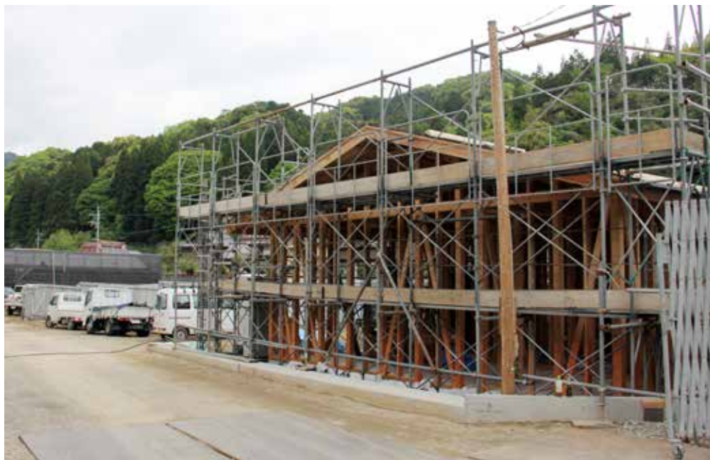
▲7月末完成を目指して進められている「中原復興住宅」建設工事現場の様子
