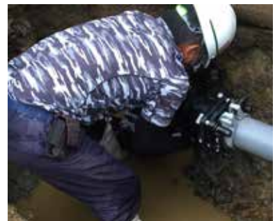
▲ 老朽化した水道管の交換
