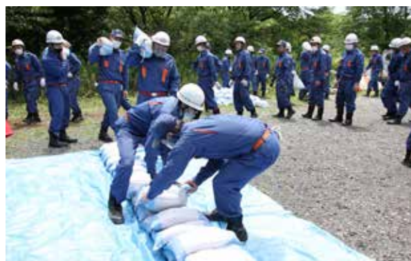
▲水防工法（積土のう工法）の様子
