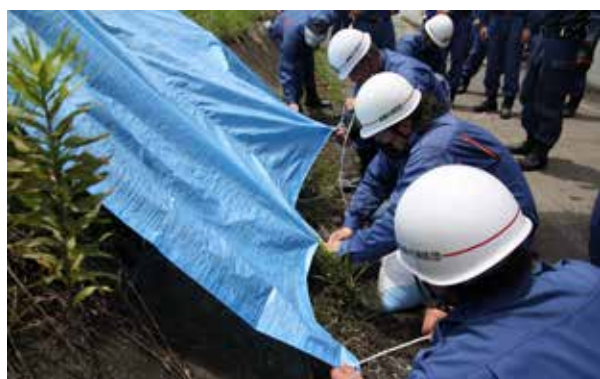
▲水防工法（シート張り工法）の様子
