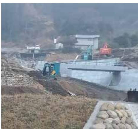
本迫川・屋椎川溪流保全工事
