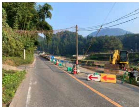
令和3年度は上福井地区屋敷付近を工事
