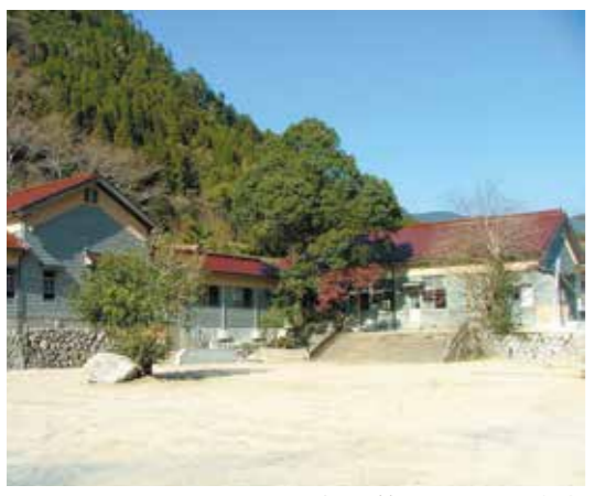
被災前のほうしゅ楽舎
