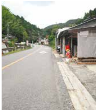
鶴地区の歩道のない区間
