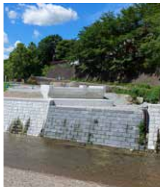
建設中のBRT橋台
