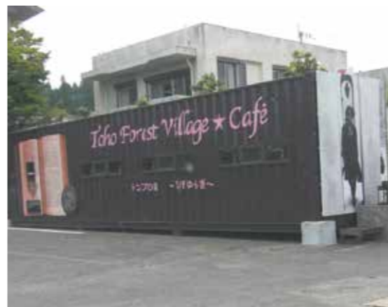
役場駐車場のコンテナ
