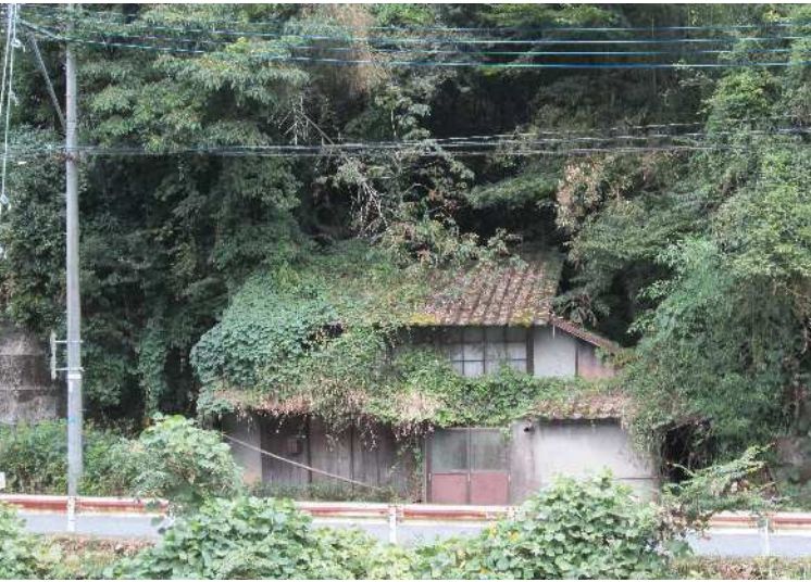
国道211号線鶴地区久毛付近
