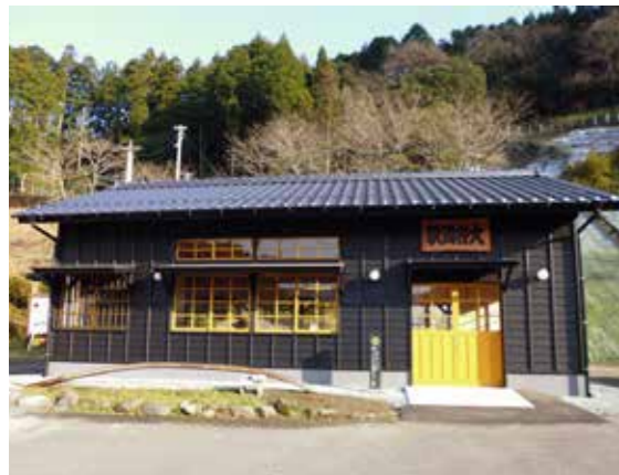
令和元年12月21日、被災した大行司駅舎も再建
