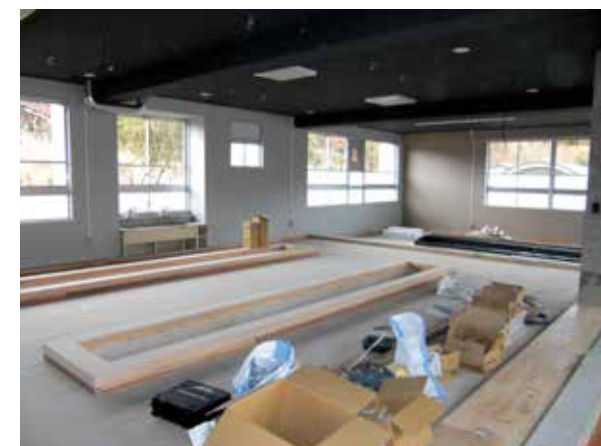
囲炉裏の間(元家庭科室)
