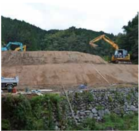
東峰村ライスセンター造成工事
