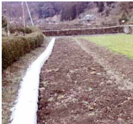
畦畔コンクリート
