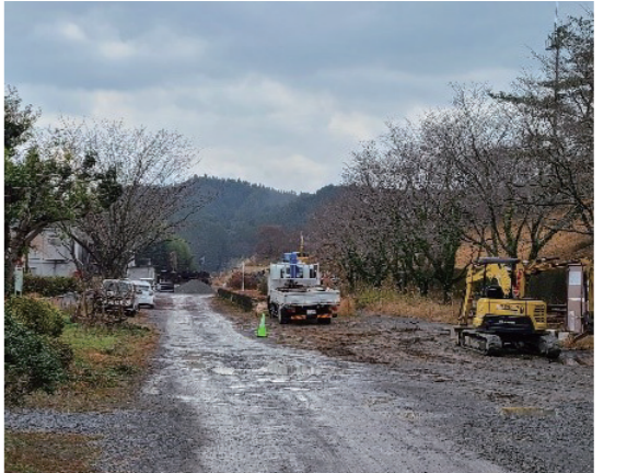
工事中の宝珠山駅
