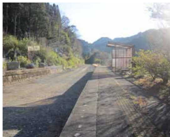
線路を撤去した大行司駅
