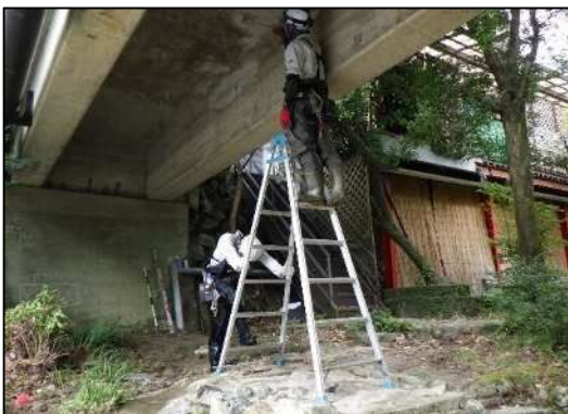
[ 脚立による定期点検状況 ]
