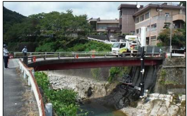
[ 橋梁点検車による定期点検状況 ]
