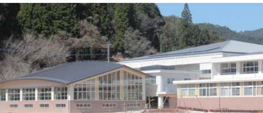
新設の武道場
